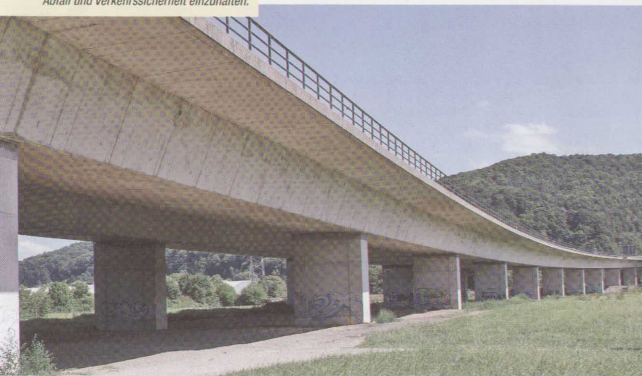
Seit Sommer 2010 dürfen die Pfeiler einer Autobahnbrücke an der A98 bei Lörrach von Graffiti-Sprayern besprüht werden
